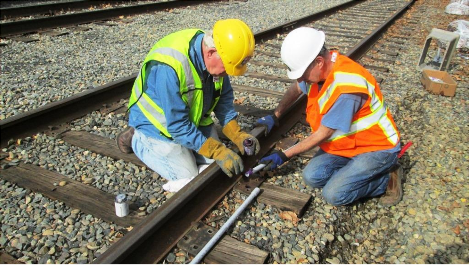
Jim and Dennis extend the conduit
